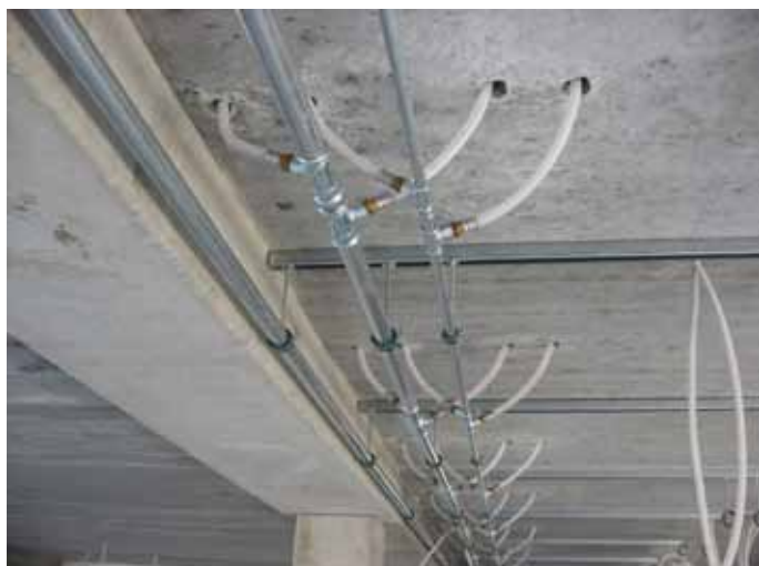
Abb. 8 Deckenuntersicht im Rohbau
